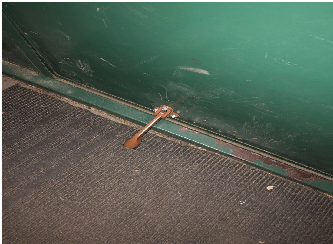
Ремонт дверного упора
