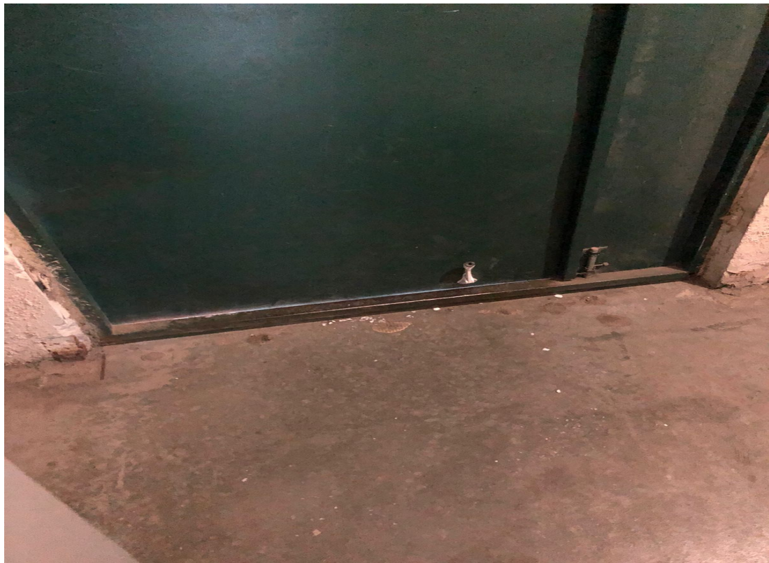
Монтаж противоскользящего покрытия в тамбуре
